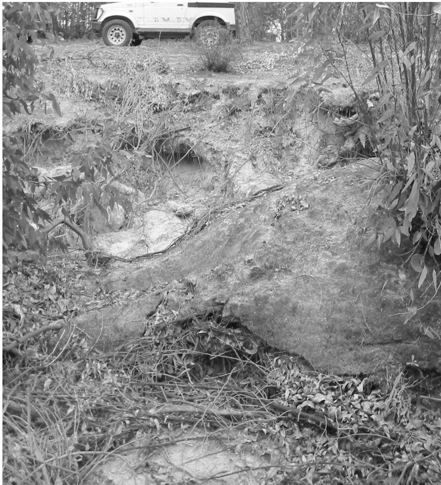
Figura 10. Resultado de la erosión subsuperficial en el arroyo de Valdeconejos. El nivel de arenas culminante es desalojado por flujos subsuperficiales asociados al muro limoso menos permeable.
