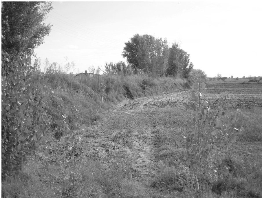
Figura 6. El recrecimiento artificial de las orillas en el arroyo Calancha provoca la desconexión del cauce con su llanura aluvial, quedando topográficamente por encima de ella.
